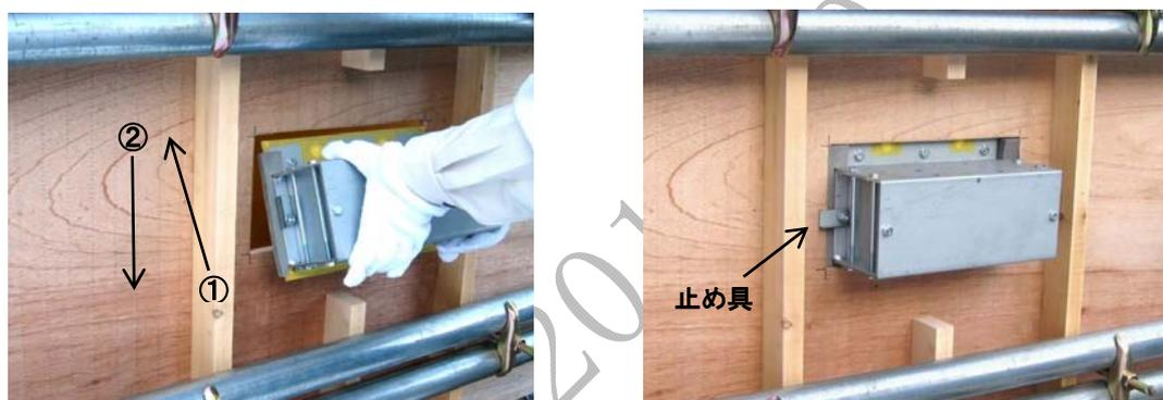
a) ボス型枠の取付け状況
