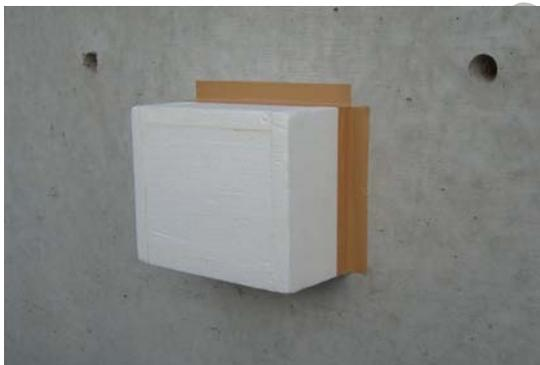
解説図 22—簡易断熱養生（例）
