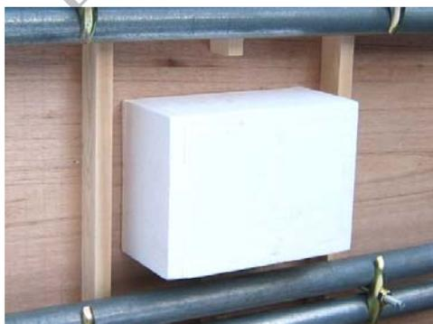
解説図 19—断熱養生 (例)
