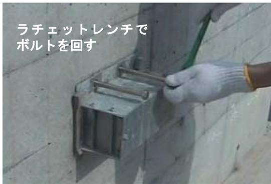
解説図 26—ボス型枠の割取り方法
