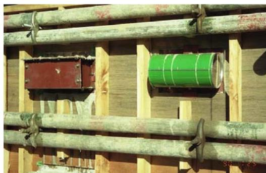
b) 直方形ボス型枠と円柱形ボス型枠
